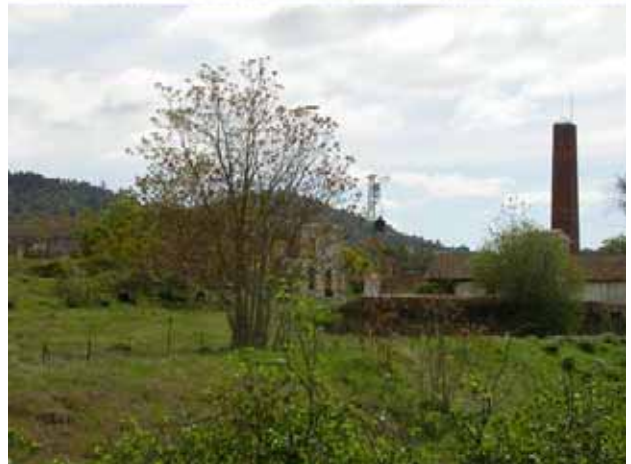
FOTO 157. Fábrica de El Pedroso. Ruinas de las instalaciones industriales para el tratamiento mineral.
